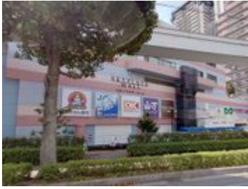
ユウカリが丘スカイプラザ・モール
