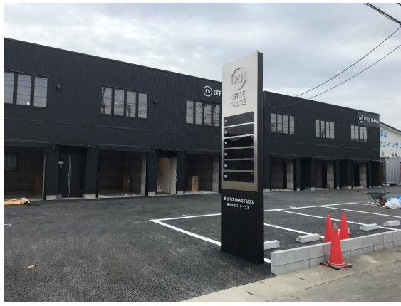
R9 OFFICE GARAGE 藤岡(1).
