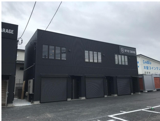
R9 OFFICE GARAGE 藤岡(2).
