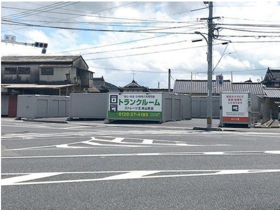
津山院庄トランクルーム 外観
