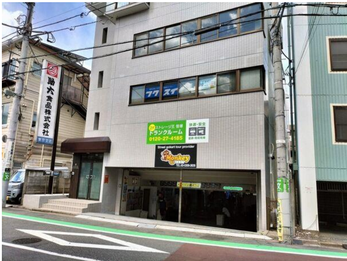
笹塚トランクルーム外観
